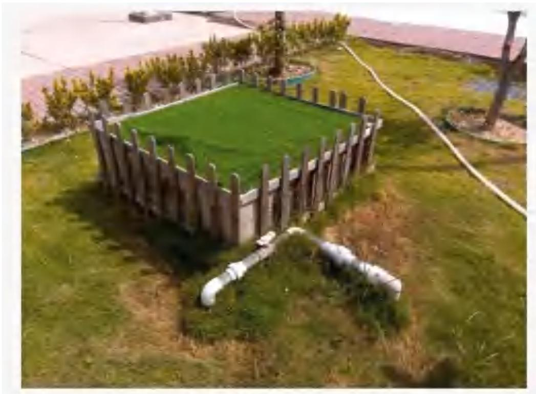
图 6.3-1 饶平分输站地埋式一体化小型生活污水处理设备
